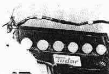
Figura 48. Situación de la batería.
